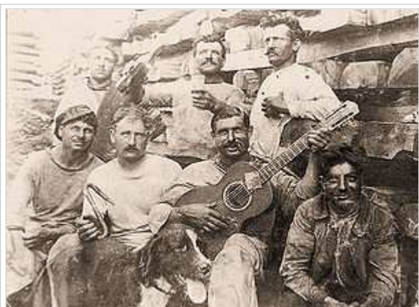
Ouvriers à l'usine de fabrication et de créosotage de traverses de Montérolier-Buchy en 1932
