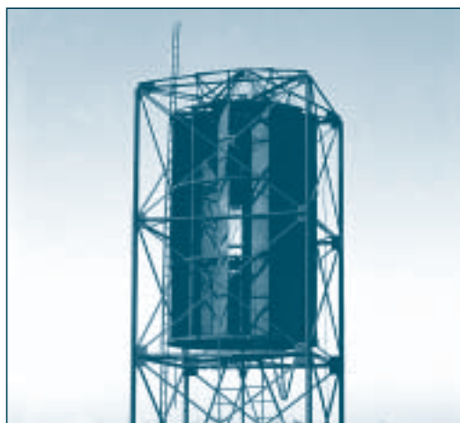
Turbine Lafond du domaine de Jarras Listel au Grau-du-Roi.
