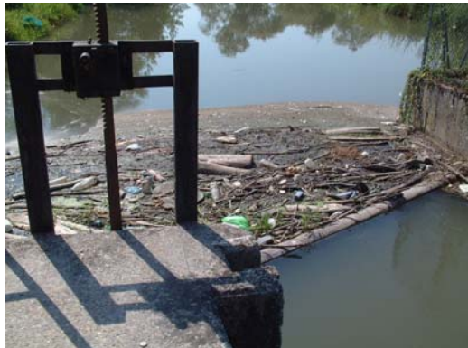
Plan d'Eau - Barrage-écluse à l'entrée du Giessen
