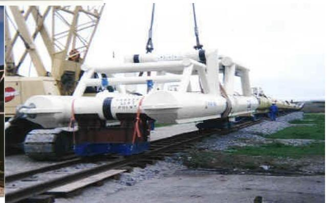
(triple) conduite d'eau froide mise dans l'océan sur des rails à hawaii (USA), en utilisant la même technique que George CLAUDE en 1930.
